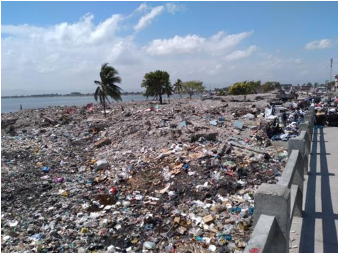
Photo: Une vue vers la mer de Shada Cap-Haïtien après la destruction.
